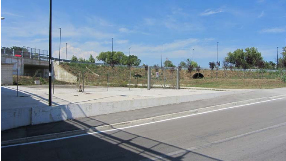
Foto 22 – Vasca 5.a . Da sx: manufatto recintato con pavimentazione, pista, tubi, sistemazioni a verde
