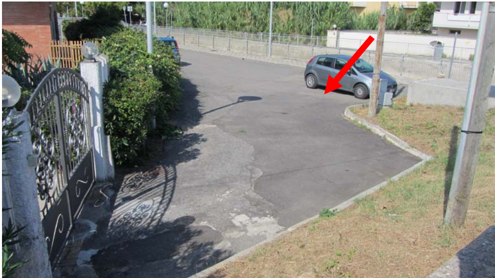
Foto 33 – Particolare sedime vasca interrata di 1° pioggia n° 8 (freccia)
